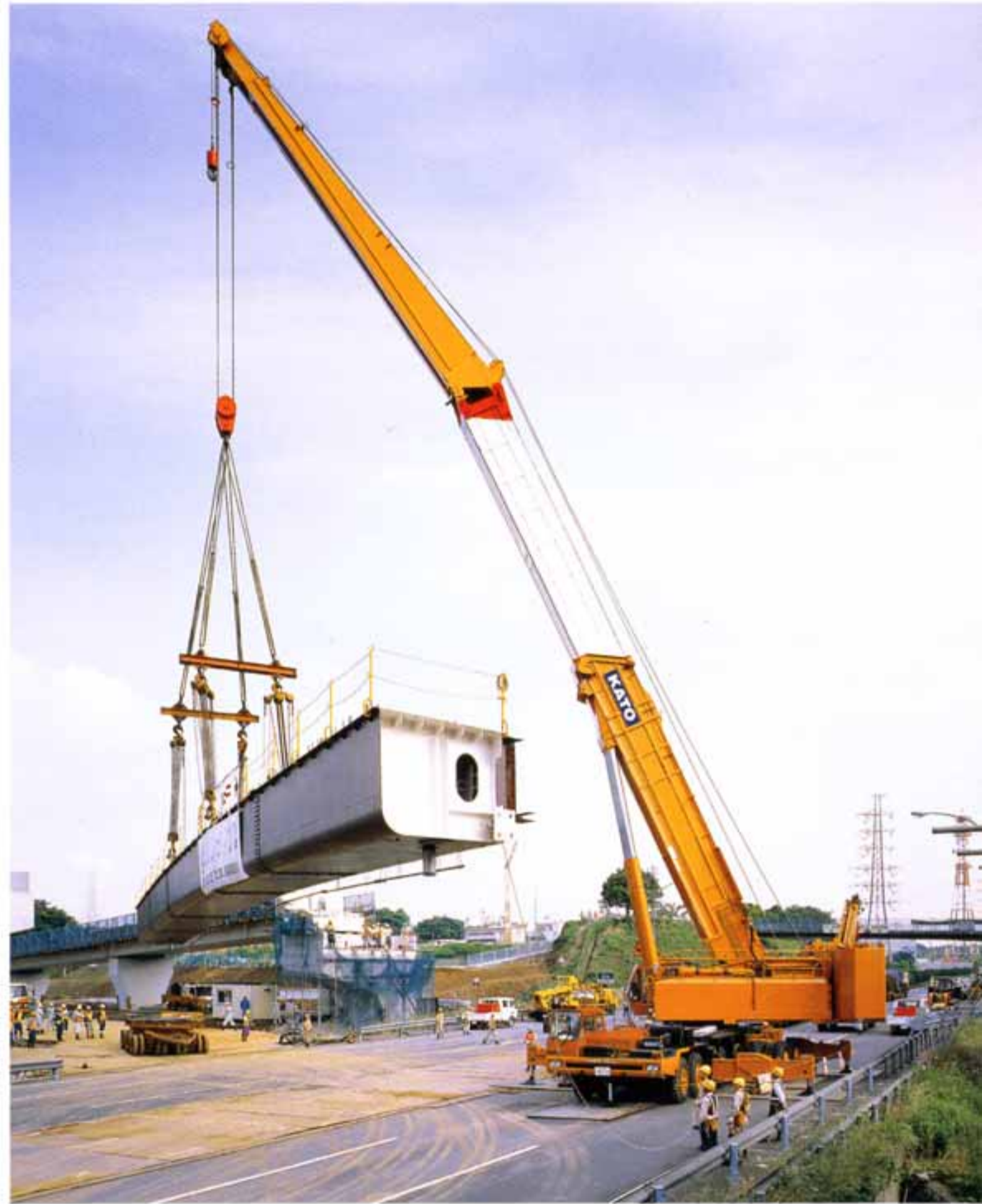
第三京浜道路 新港北IC橋桁架設工事
